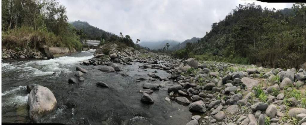
Imagen 5: (izq.) Salida de agua de la central hidroeléctrica Hidrotambo (margen derecha del río).
