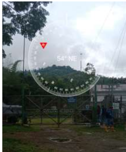
Foto 3: Instalaciones del centro de máquinas de Hidrotambo
