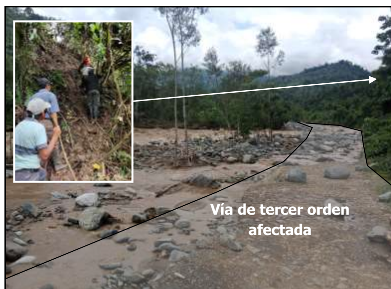
Foto 1: Se muestra el trazado con su base invadida por el río, esta vía conecta a San Pablo de Amalí con San José del Tambo y el recuadro blanco se muestra la actual ruta de acceso.
