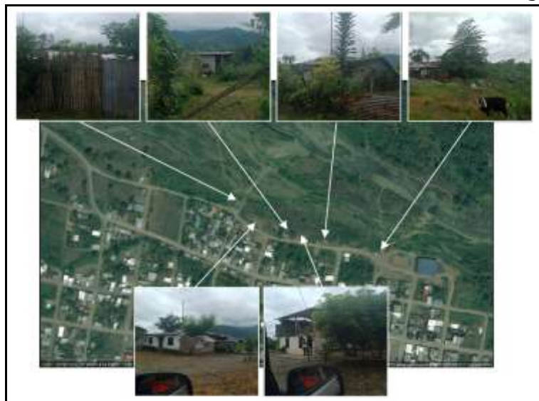
Imagen 6: Se evidenció varias viviendas levantadas zonas que anteriormente fueron arrasadas por las crecientes.
