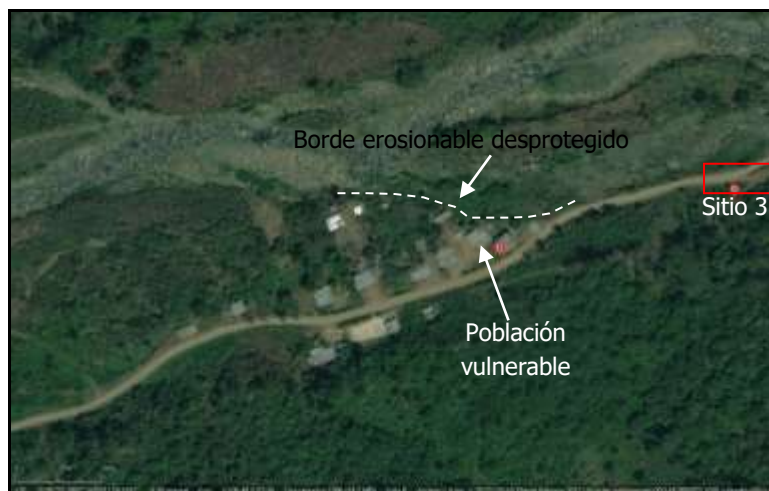
Imagen 3: Se muestra a través de una imagen satelital proporcionada por SasPlanet del año 2017 donde se observa la forma del río y casas vulnerables ante las avenidas de agua y la erosión de sus bases.
