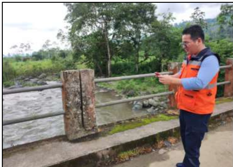
Foto 4: Inspección a puente Dulcepamba.
