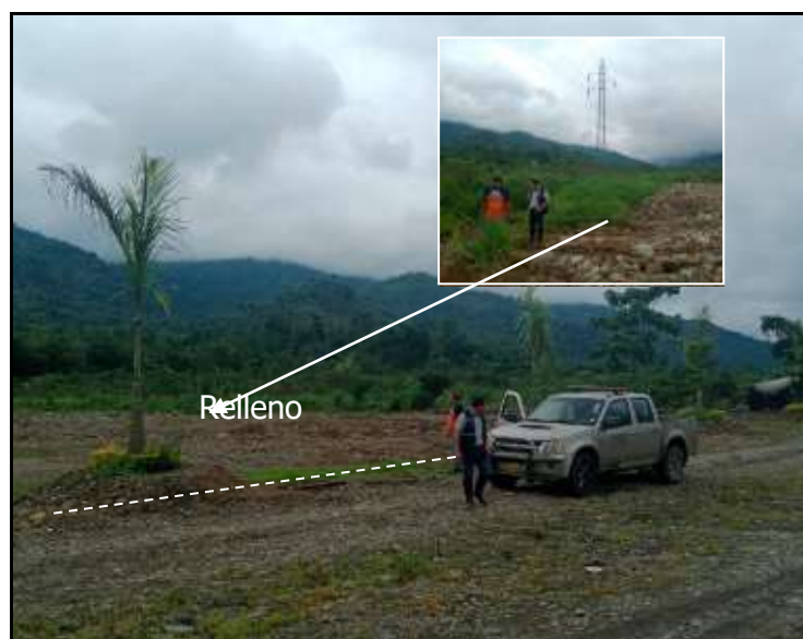
Foto 3: Se muestra área rellenada recientemente sobre terraza media. En el recuadro blanco se muestra relleno junto al cauce.
